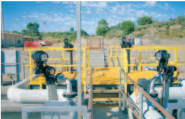
在澳大利亚水厂的多回转执行器/蜗轮齿轮箱配置
