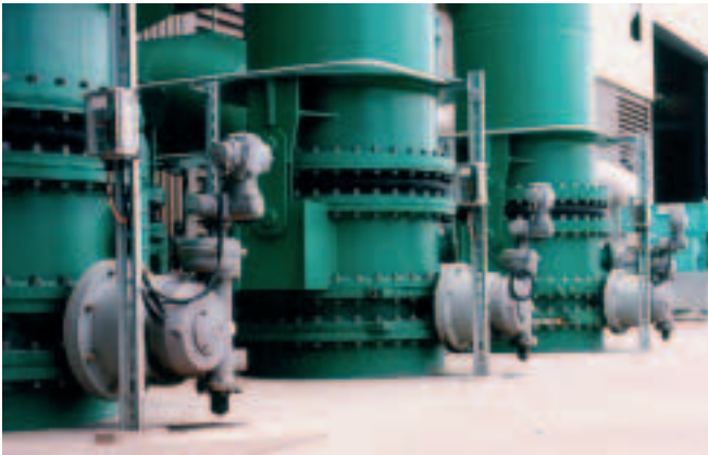
澳大利亚电厂的脱硫设备里，带初级减速齿轮的GS 500和安装的SA多回转执行器。
