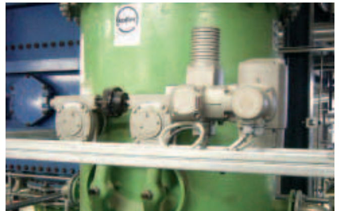
一个非常特别的解决方案。两个系列连接的GS齿轮箱通过一个共同的多回转执行器操作, 以便同时可以改变一个双蝶阀的设置。
